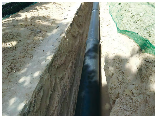
厦门 厦门水务集团有限公司球墨铸管及管件年度采购
